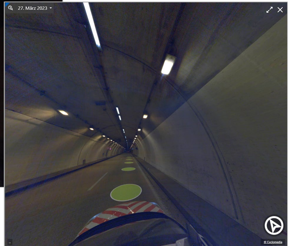
2023 Befahrung mit Wartungsbeleuchtung
